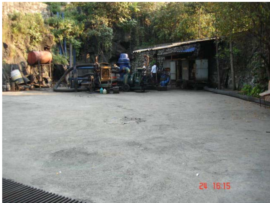
VISTA GENERAL DEL CARCAMO EL CARACOL
