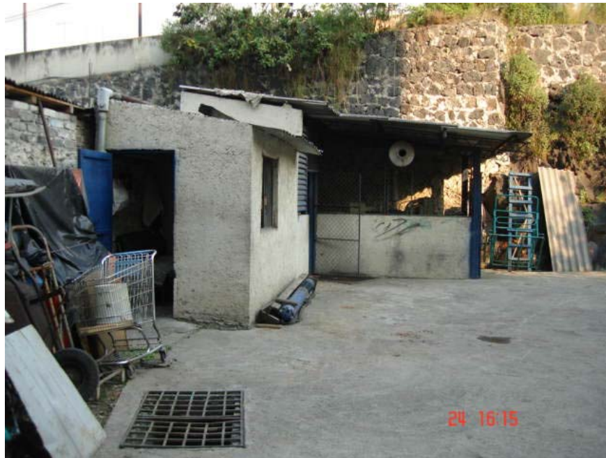
CASSETAS DE CONTROL DE MOTORES CARCAMO EL CARACOL
