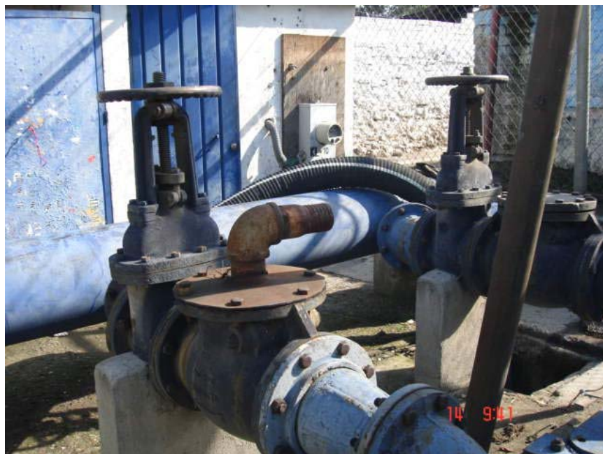
ARREGLO DE FONTANERIA DE LINEAS DE DESCARGA CARCAMO CUAUHEMOC
