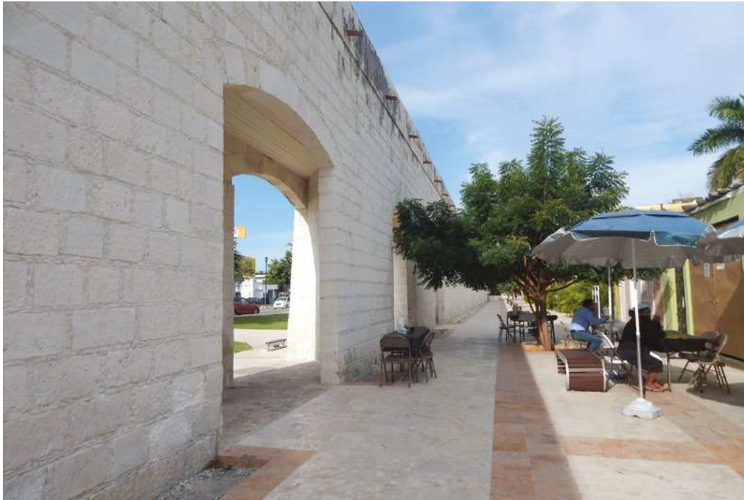
Imagen 4. Lienzo de muralla construido sobre la calle 18, al que se le adicionaron tres entradas en diagonal, 2014. Fuente: Archivo fotográfico de la autora.
