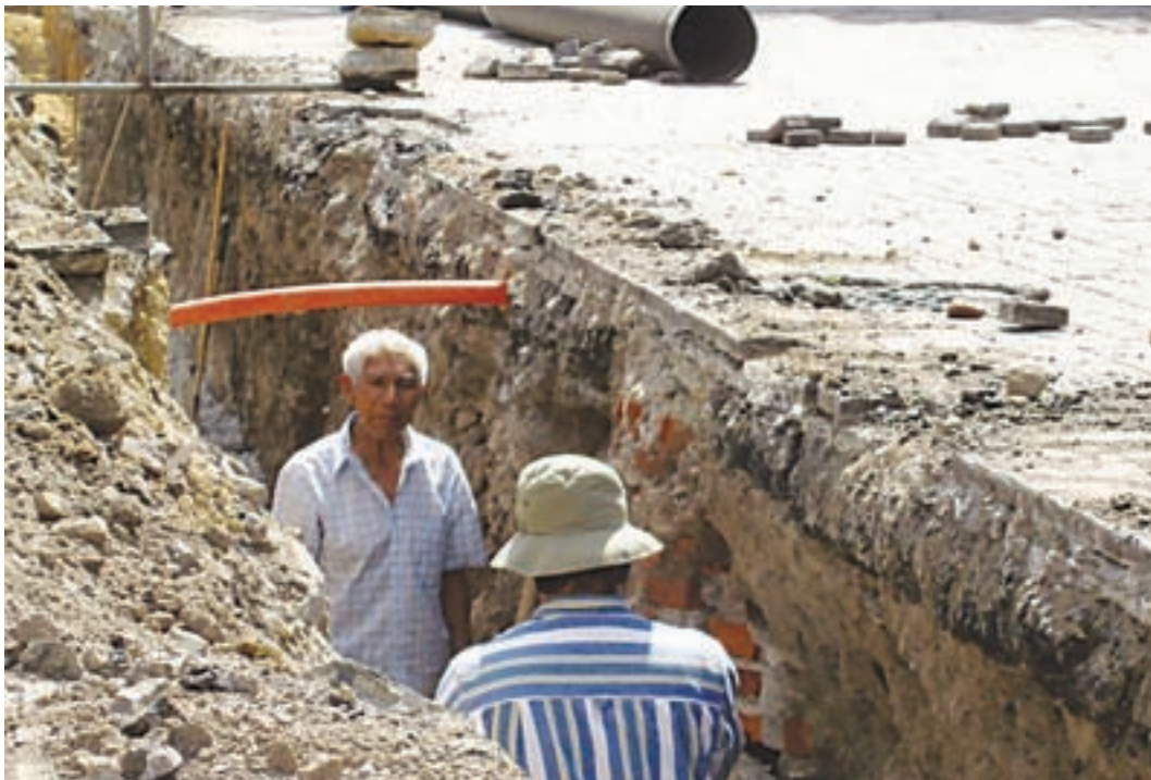
Excavación de zanja para colocación de tubería de drenaje / Fotografía de la DGO
