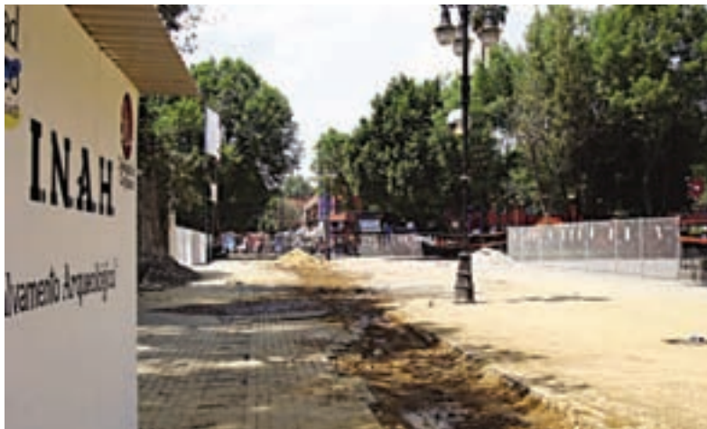
Relleno y compactación de zanjas con tepetate en obras hidráulicas / Fotografía de la DGO
