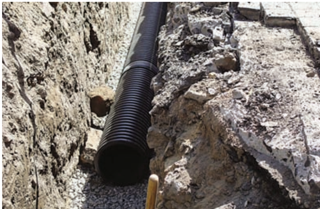
Tendido de tubería de drenaje de polietileno / Fotografía de la DGO
