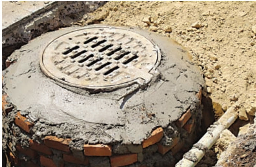
Pozo de visita en red de drenaje y, a un costado de éste, la colocación de ductos para cableado eléctrico / Fotografía de la DGO
