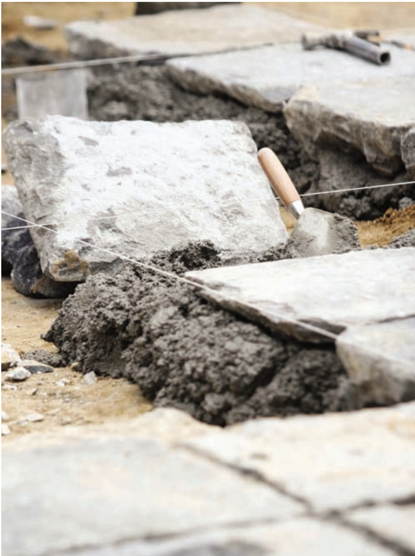
Detalle de la colocación de piedra recinto labrada a mano / Fotografía de L.C.
