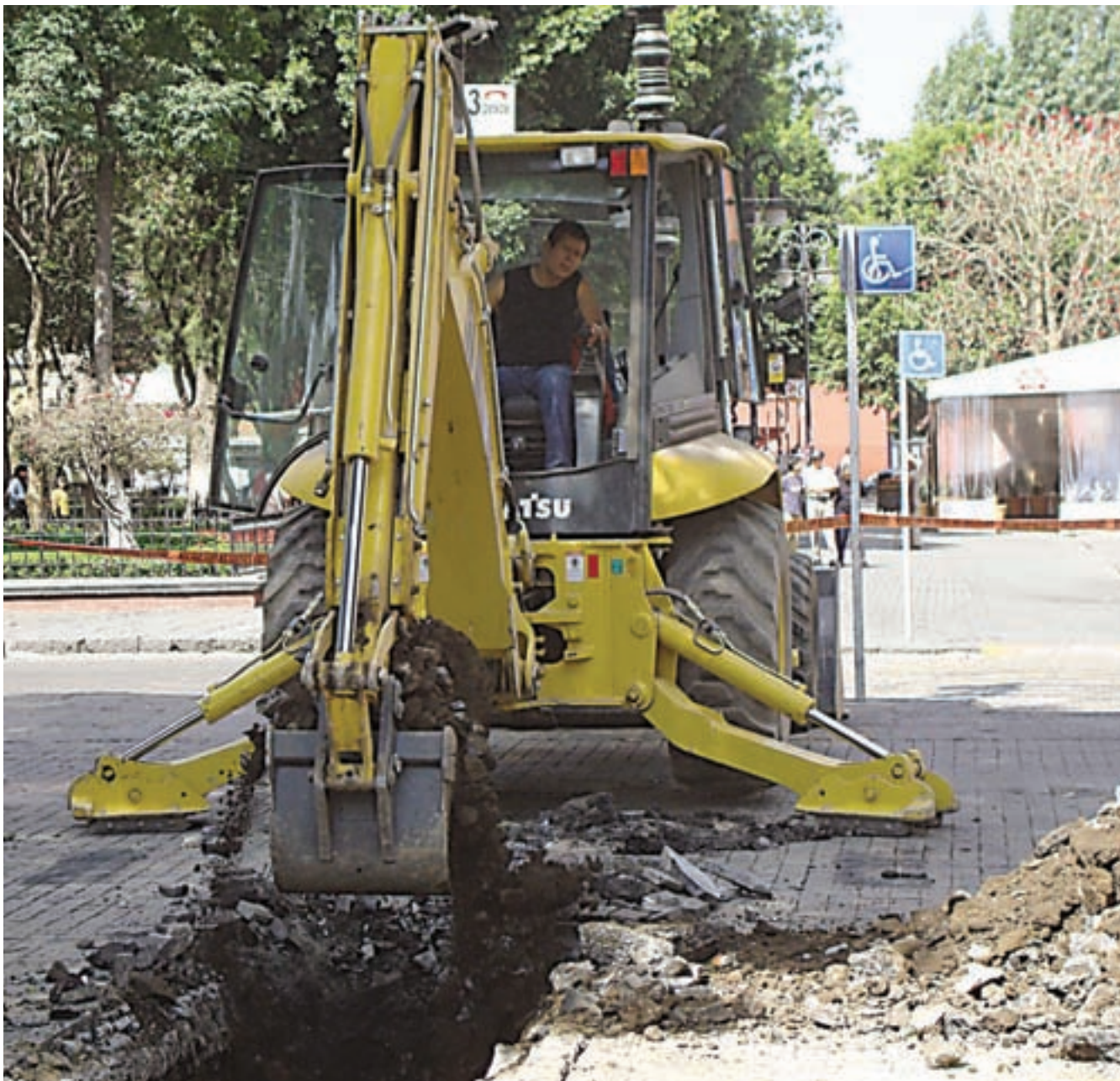
Excavación con maquinaria para introducir tubería de agua potable y drenaje / Fotografía de la DGO
