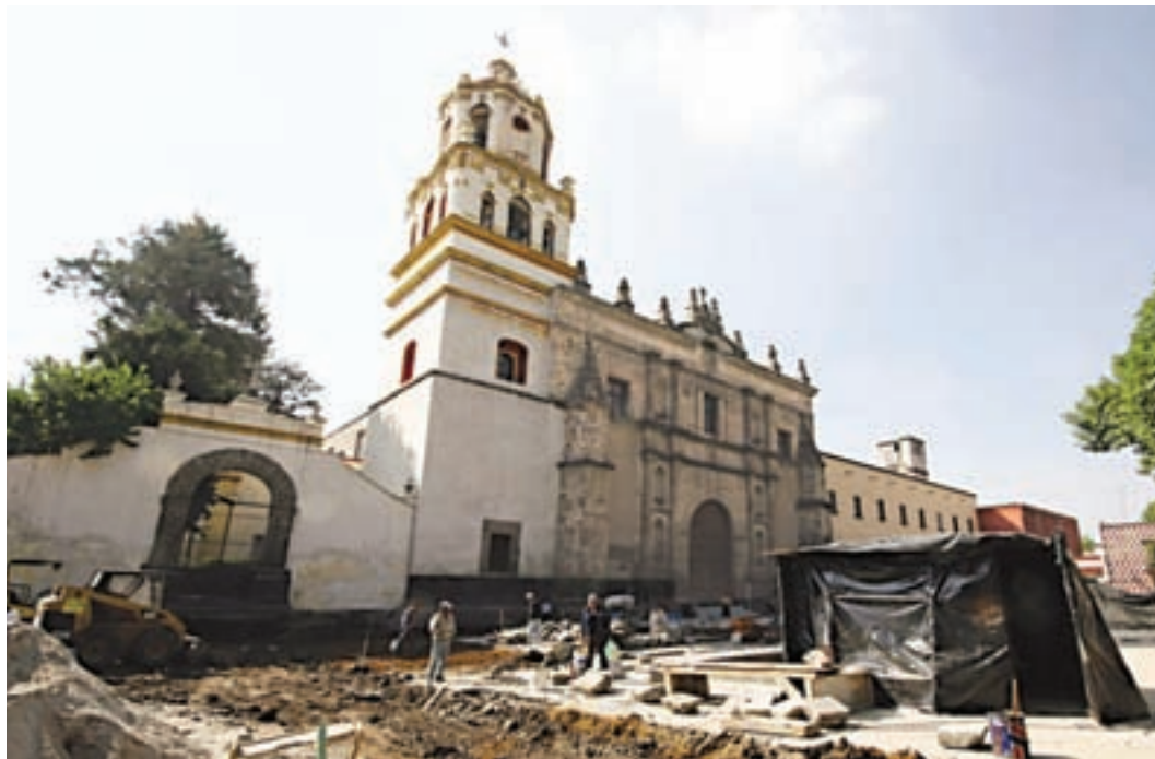
Excavación en el atrio de la iglesia de San Juan Bautista para recuperar el nivel original del piso / Fotografía de L.C.
